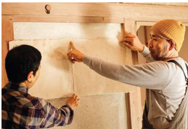
「YURUGI PROJECT」で開催したイベント 和紙壁の修復作業の様子
